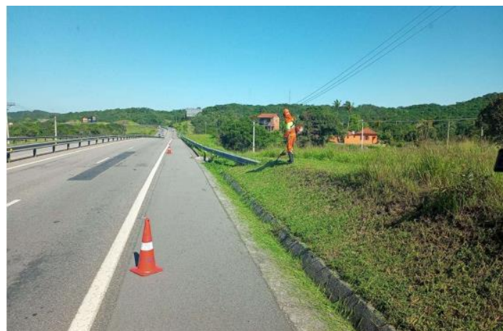
Figura 6.9 Via Lagos - Roçada Manual - Km 54+000 Sul
