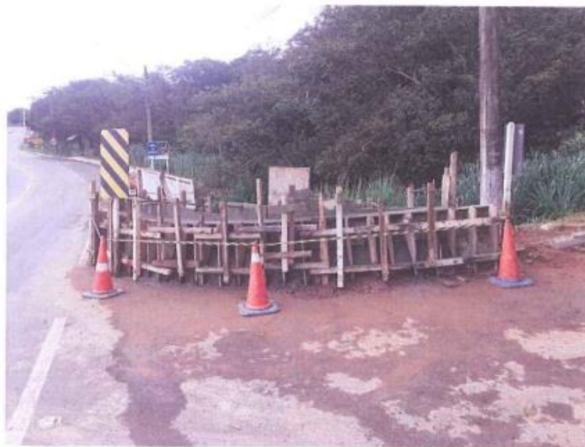
Figura 6.17 Rota 116 – Implantação de passarela para pedestres– Km 132 + 300
