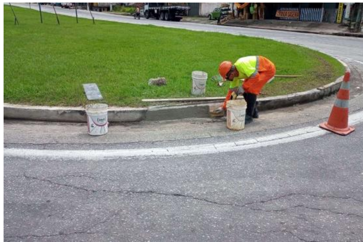
Figura 6.7 Via Lagos - Recuperação de Meio Fio - Km 0+700 Sul
