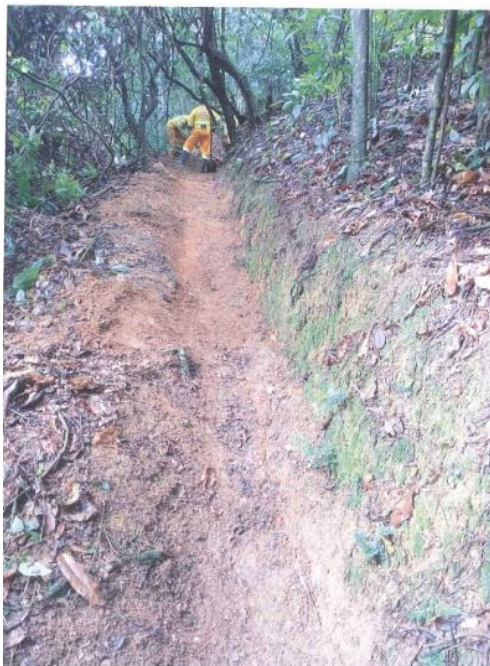
Figura 6.21 Rota 116 – Limpeza e Recuperação de drenagem – km 39,5
