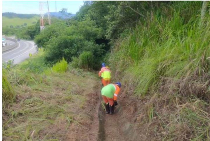
Figura 6.13 Via Lagos - Limpeza canaleta de concreto - Km 05+000 Norte
