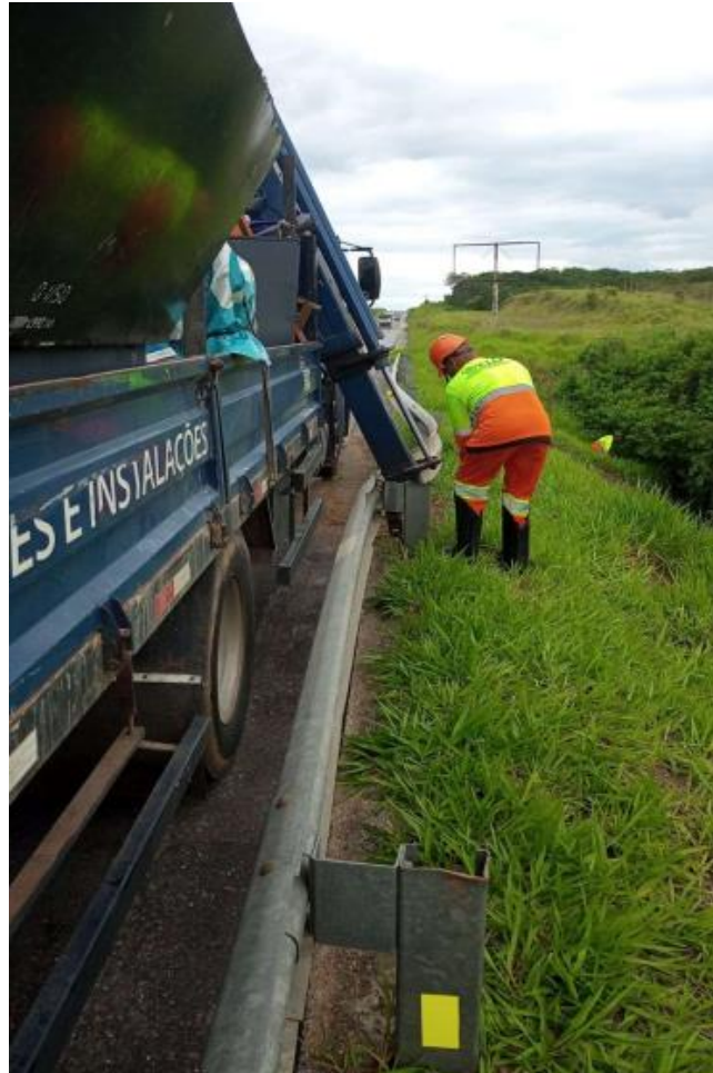
Figura 4.5 Via Lagos - Dispositivo de Segurança - Km 49+800 Sul
