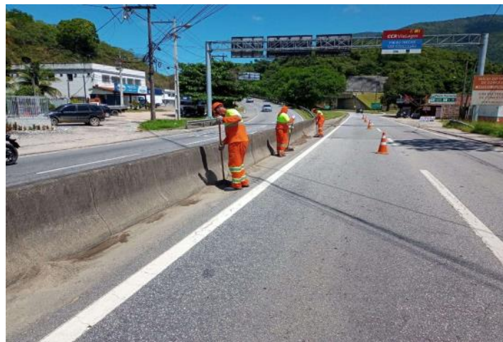
Figura 6.11 Via Lagos – Varrição Barreira de Concreto - Km 0+000 Sul
