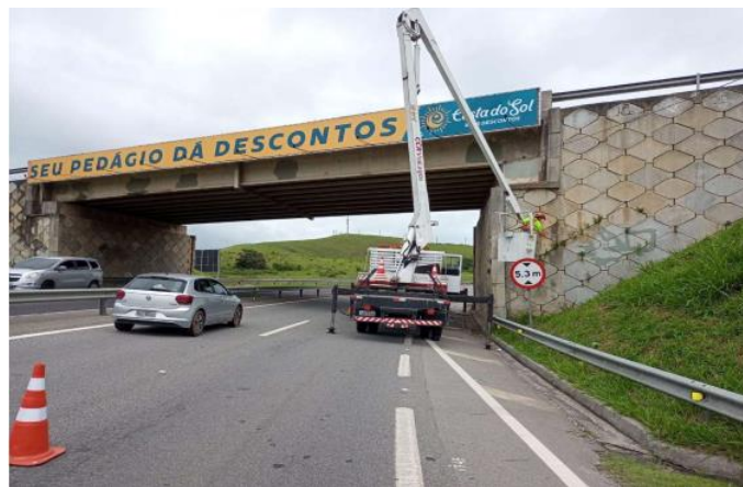
Figura 6.8 Via Lagos - Limpeza de Viaduto - Km 56+800 Sul
