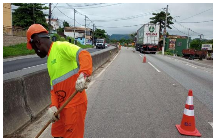
Figura 6.12 Via Lagos – Varrição Barreira de Concreto - Km 13+000 Sul
