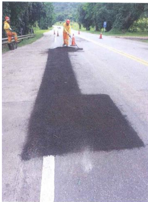
Figura 6.19 Rota 116 – Recuperação de pavimento – km 37,8
