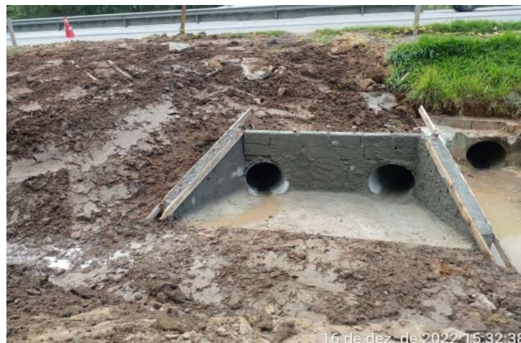
Figura 6.14 Via Lagos - Execução ala-bueiro - Km 18+200 Norte
