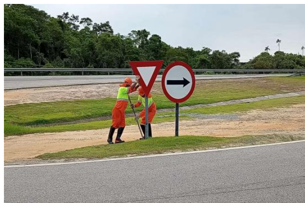
Figura 6.4 Via Lagos - Nivelamento de Placa - Km 29+120 Norte
