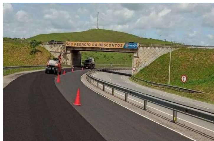
Figura 6.15 Via Lagos - MICROREVESTIMENTO - KM 56+210 Norte
