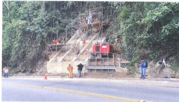
Figura 6.18 Rota 116 – Obra emergencial de contenção – km 44 .1 S
